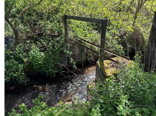
Rückbau einer Wehranlage, Quelle: GUV F/U/W
