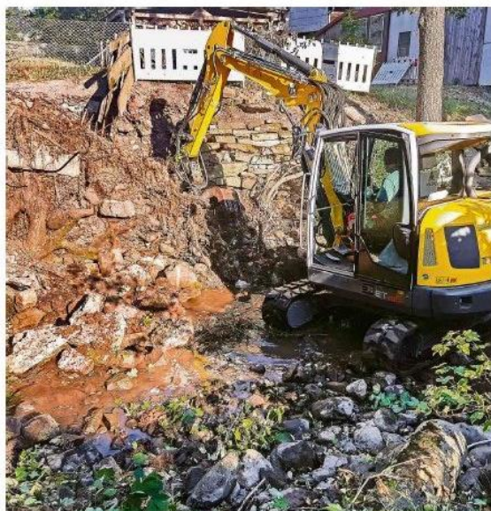
Nach einer Windhose sicherten die Verbandsmitarbeiter an der Mühle in Glattbach eine Böschung, die in die Ulster zu stürzen drohte.
