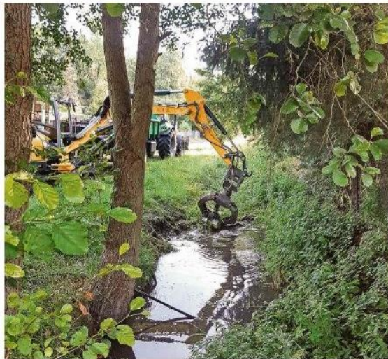
In Unterrohn wurde der Salzgraben ausgebaggert.
