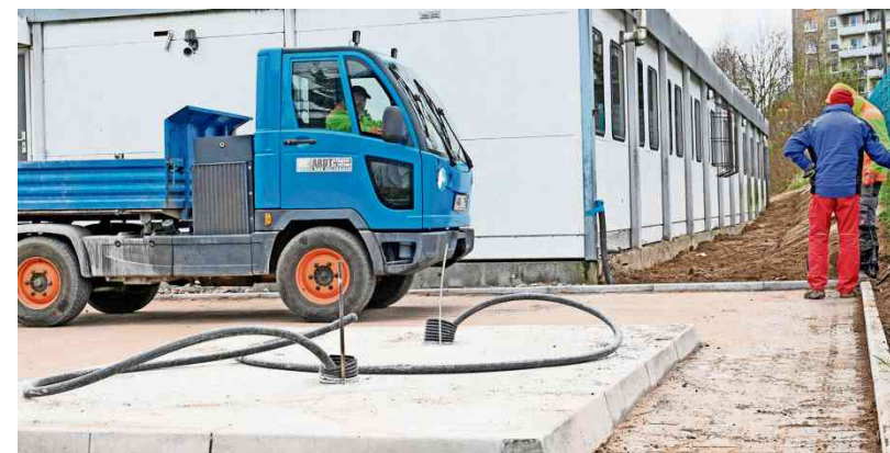
Auf dem Betriebshof in Bad Salzungen wurden bereits die Kabel für die Ladesäulen verlegt. Foto: Heiko Matz
