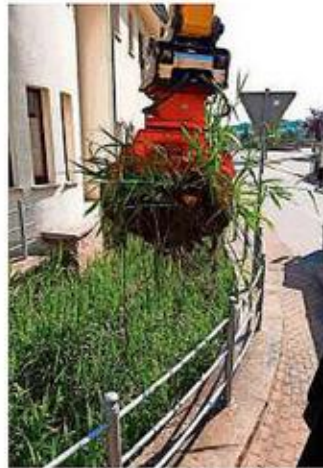
Baggereinsatz und Querschnittsberäumung am Breizbach in Unterbreizbach.
