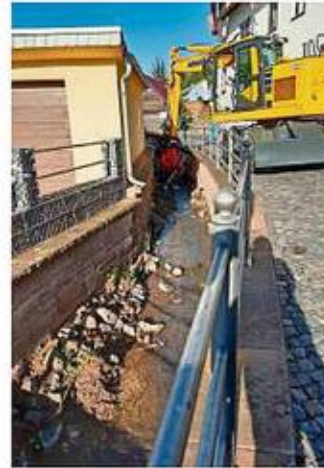
Baggereinsatz und Querschnittsberäumung am Breizbach in Unterbreizbach.
